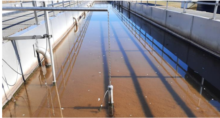
Abbildung 10: Kammer II des Belebungsbeckens II mit Sauerstoffmesssonde
