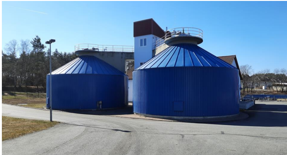
Abbildung 15: Zwei Faulbehälter
