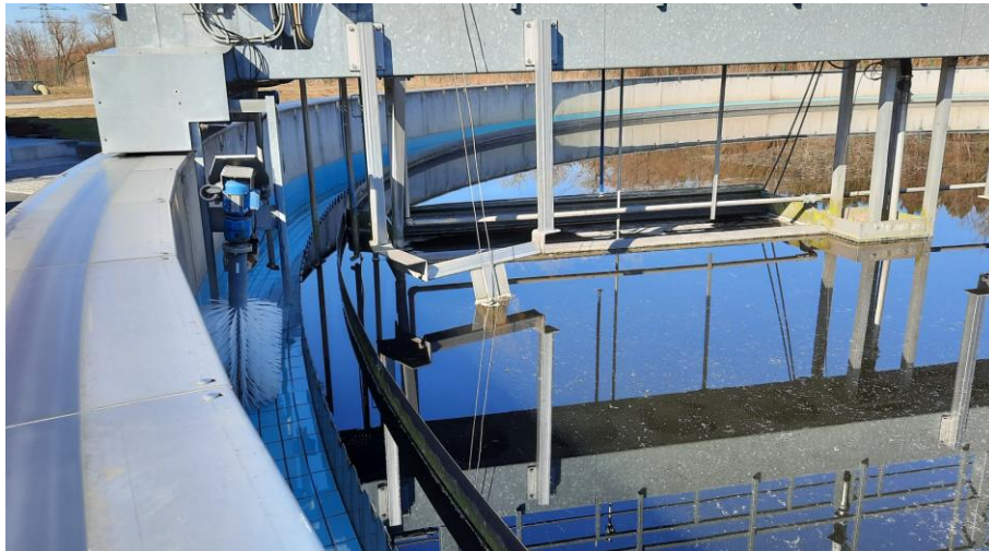
Abbildung 12: Nachklärbecken mit Tauchwand und rechteckiger Abflussrinne
