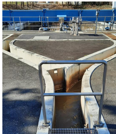
Abbildung 7: Trennbauwerk des Zulaufkanals zum Vorklärbecken bzw. Pufferbecken
