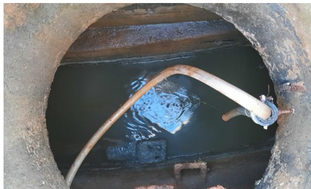
Abbildung 11: Dosierstelle Fällmittel
